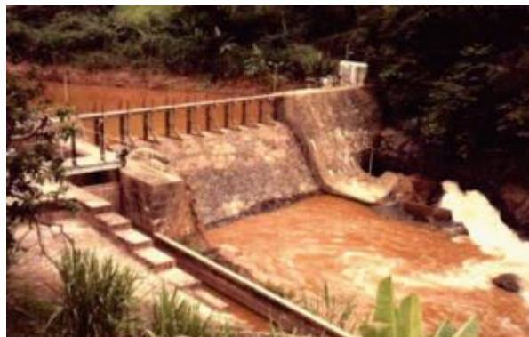
Figura 3 - Usina Marmelos, detalhe do barramento vertente
