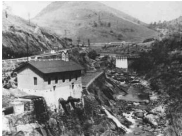
Figura 2 - Usina Marmelos, vista geral de jusante para montante com casa de força em primeiro plano e barramento vertente ao fundo
