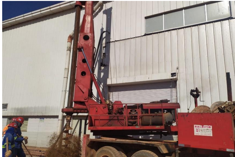
Figura 4 – Escavação com perfuratriz
