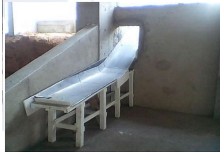
Figura 14 - Escorregador de materiais.
