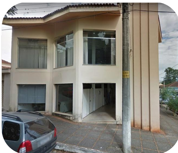
Figura 6 – Fachada local do estágio
