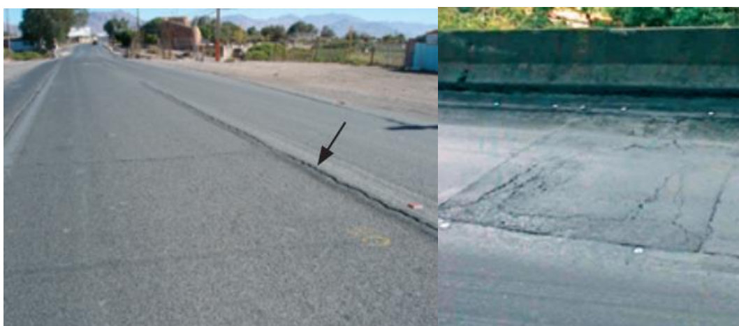
Figura 8 – Diferentes tipos de Trincas de Retração
