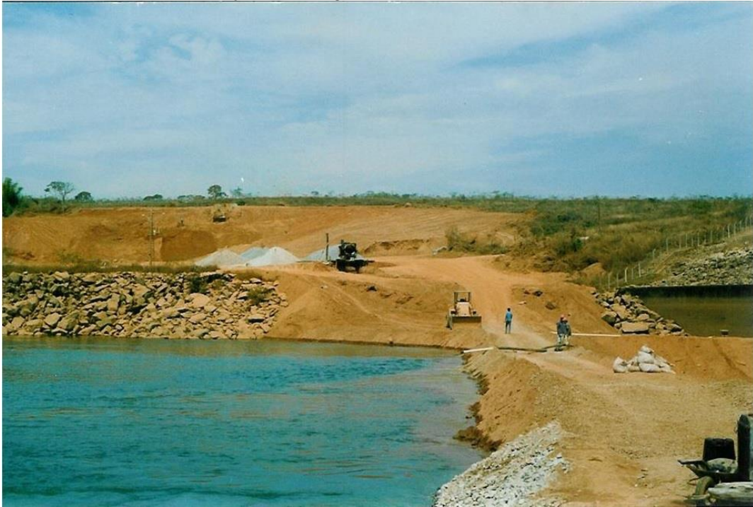
Figura 2 - Vista frontal da área de estudo, onde, em 1991, foi construída enseadeira para viabilizar obras de manutenção na barragem, com nova retirada de terra no local.
