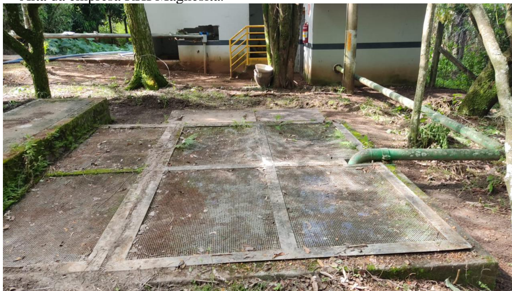
Figura 4 - Unidade de decantação do tratamento de efluentes industriais da unidade Ponte Alta da empresa RHI Magnesita.
