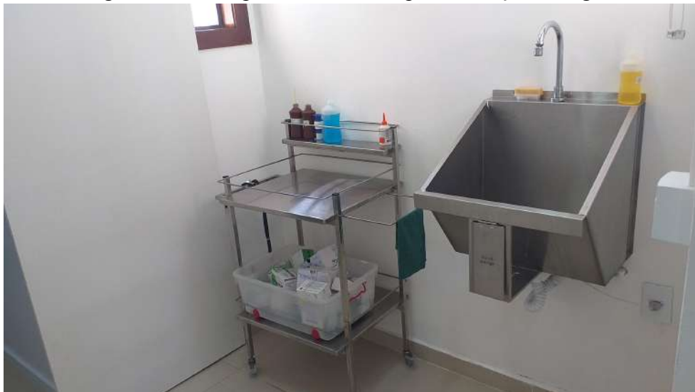
Figura 15 - Vista parcial da sala de paramentação cirúrgica
