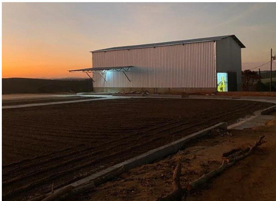
Figura 1 - Galpão de beneficiamento da Fazenda Alto das Seriemas
