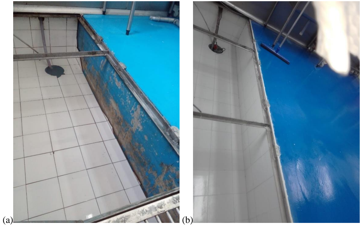
Figura 29 – Bacia de contenção de efluentes em um setor produtivo de uma indústria farmacêutica veterinária em situação (a) não conforme e (b) em conformidade com às BPF.
