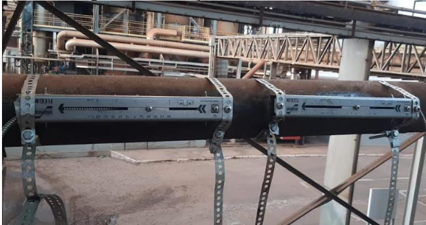
Figura 21 - Instalação do medidor de vazão
