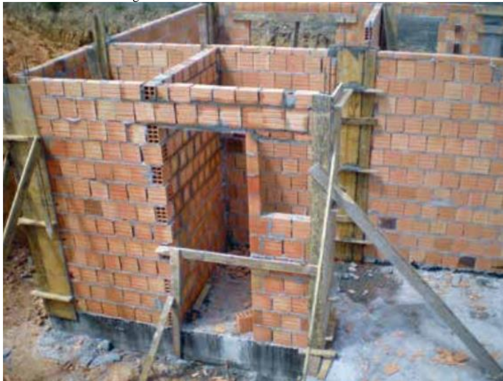
Figura 1 – Estrutura de convencional de alvenaria
