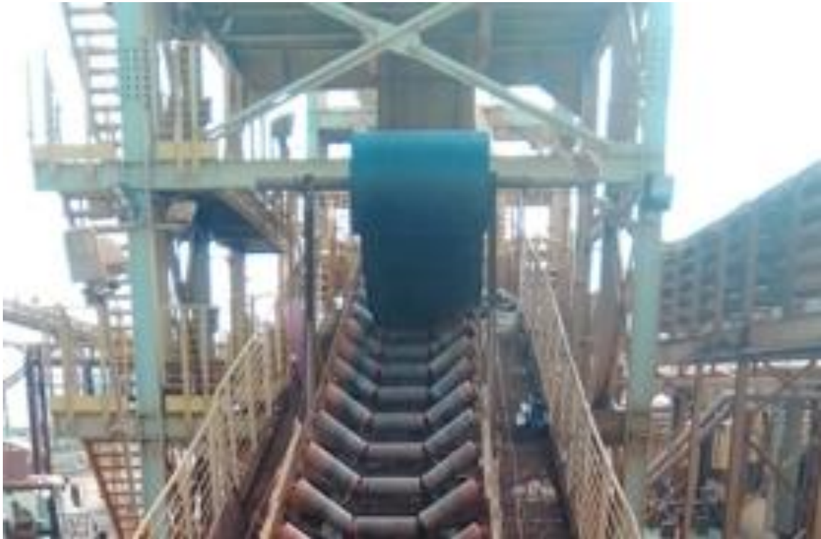
Figura 30 - Correia sendo alocada no transportador
