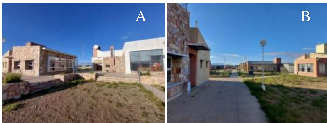
A – Salão de Capacitações à esquerda e Prédio Administrativo ( Casa Solar ) à direita; B - Salão de Capacitações à esquerda e vista geral da EEA. Fonte: da autora (2023).
