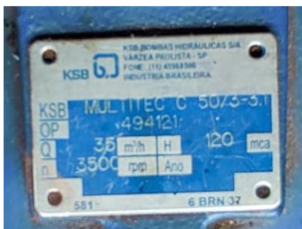
Figura 8 – Dados de placa da bomba.
