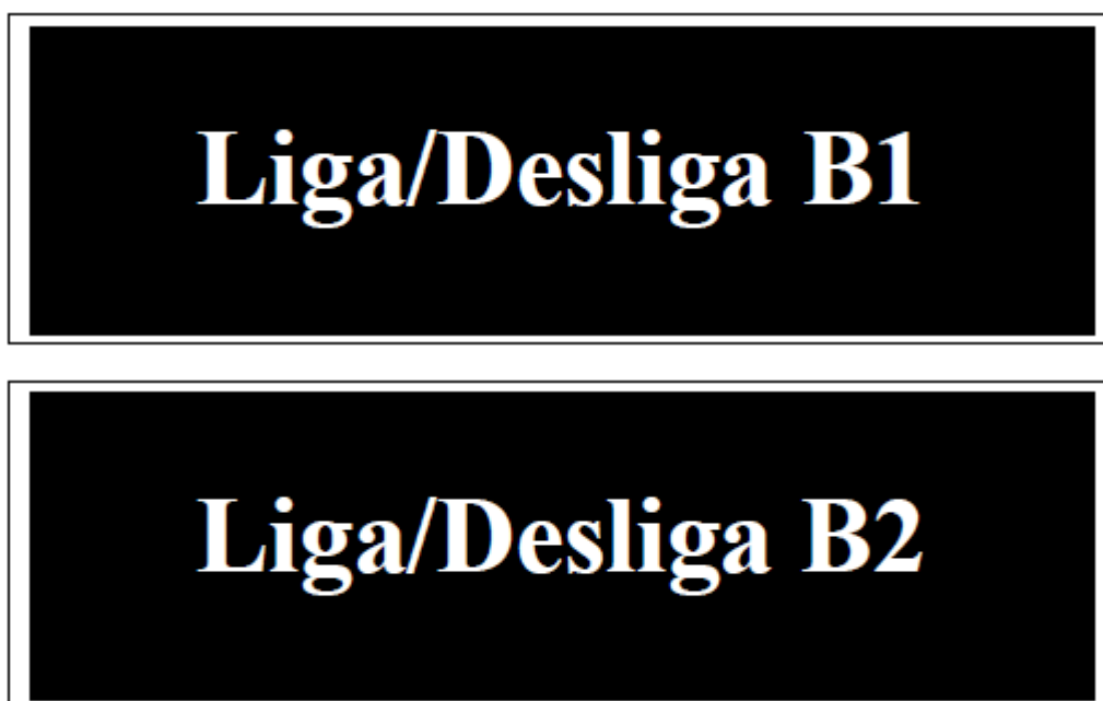
Figura 19 - Identificação de painéis elétricos.
