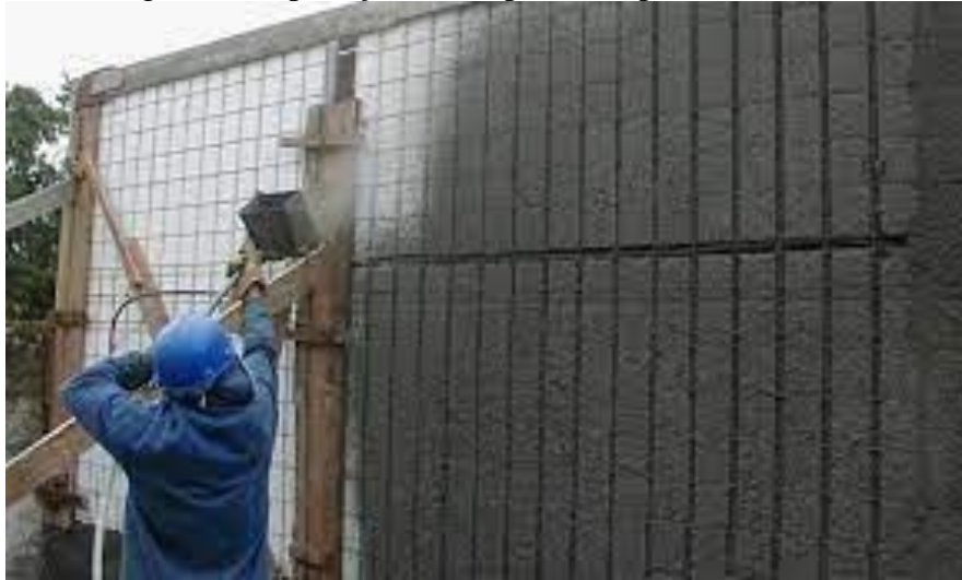
Figura 8 – Aplicação de chapisco em paredes de EPS.
