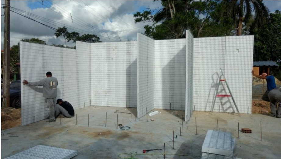
Figura 4 – Fundação para o modelo monolítico em EPS com os arranques.
