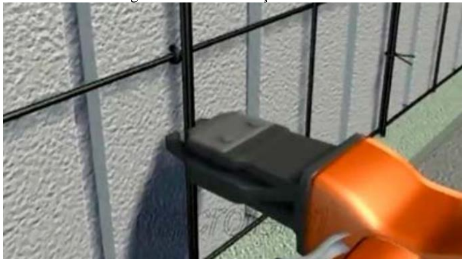
Figura 3 – Malhas de aço conectadas.
