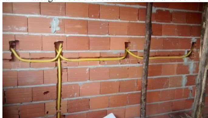
Figura 1 – Passagem dos eletrodutos na alvenaria convencional.
