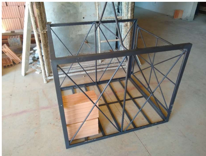
Figura 13 - Gaiola para transporte de materiais pelo guincho.
