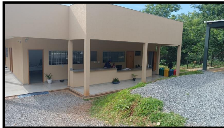
Figura 2 – Recepção, escritório e banheiros do CETAS Goiânia.
