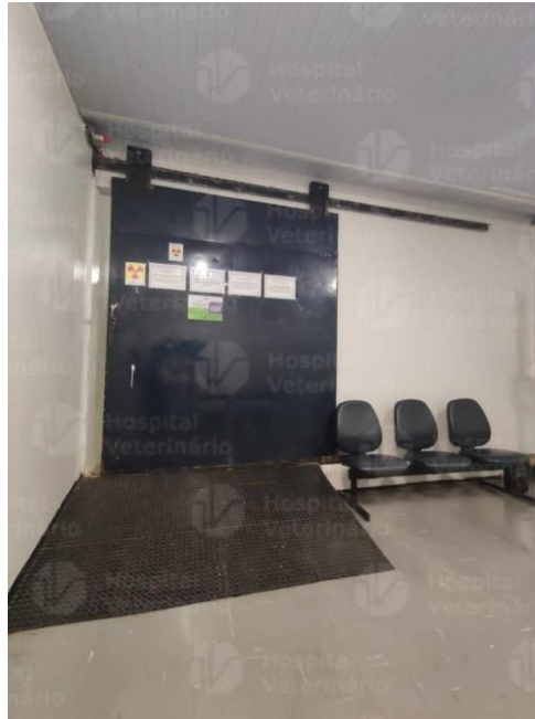
Figura 10 - Vista da entrada da sala de exames radiográficos
