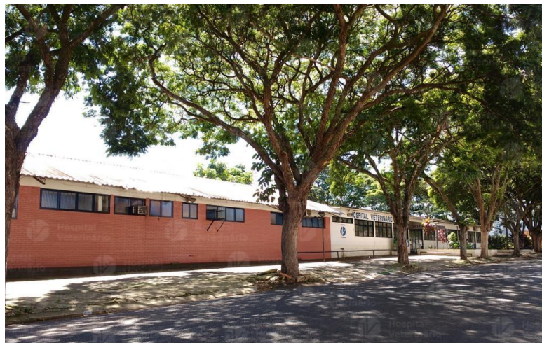
Figura 1 - Faixada do Hospital Veterinário da Universidade Federal de Uberlândia.
