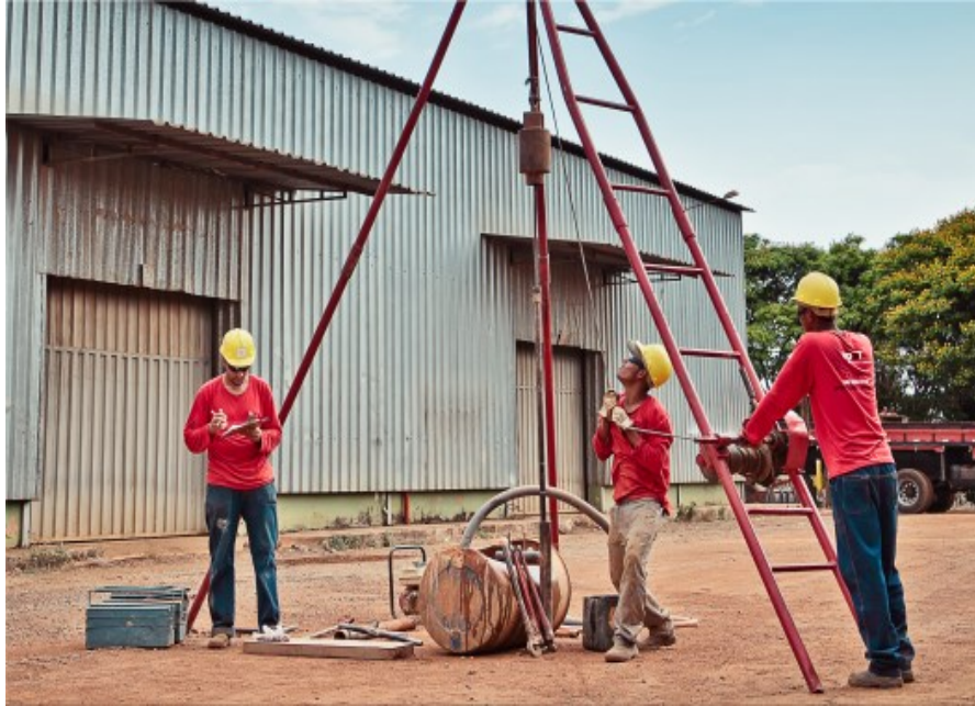
Figura 2- Sondagem a percussão com o SPT.
