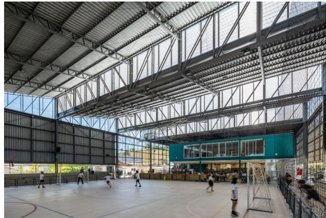
Figura 3 - Arena Castanheiras, em Santana de Parnaíba.
