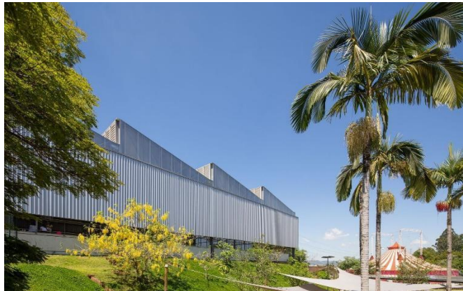
Figura 5 - Arena Castanheiras, em Santana de Parnaíba.
