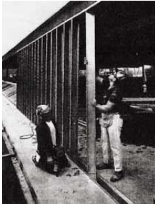
Figura 5 - Montagem do painel pelo método “Stick”
