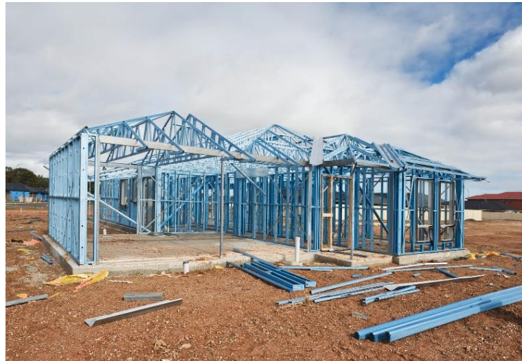
Figura 7 - Montagem do painel pelo método “modular”.
