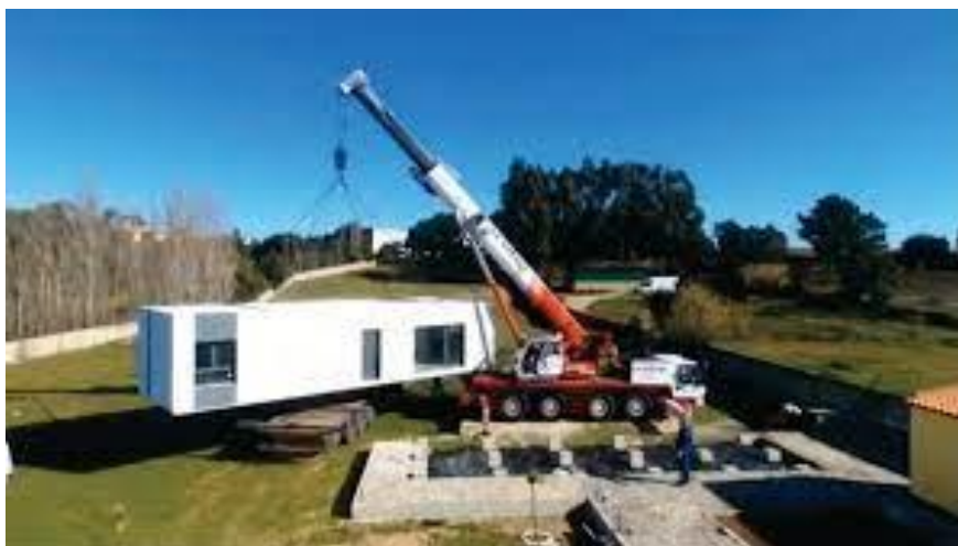
Figura 6 - Montagem do painel pelo método “modular”.
