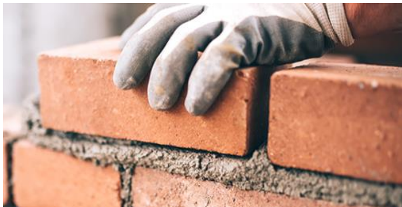
Figura 2 – Assentamento de Alvenaria
