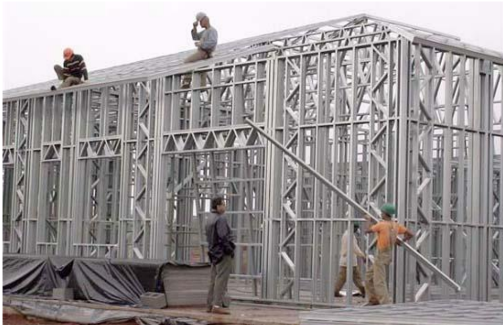
Figura 4 - Obra sendo feita utilizando Light Steel Frame .
