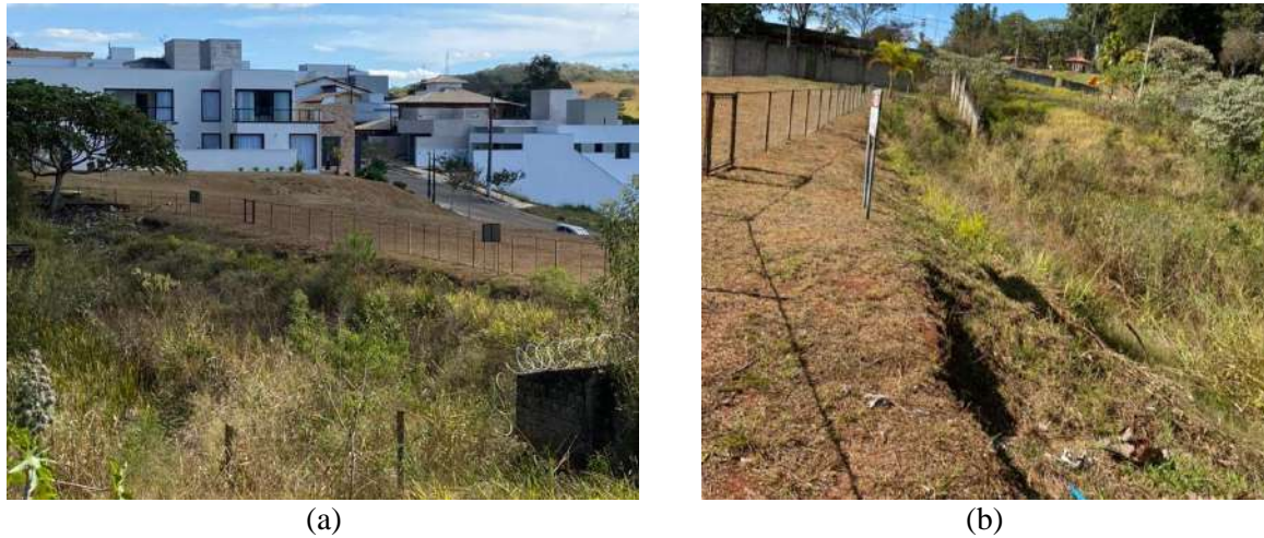
Figura 17 – Talude montante do barramento: (a) Vista frontal e (b) Vista lateral
