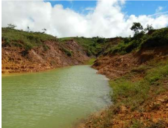
Figura 10 – Erosão no talude FEAR19, no reservatório da Usina Hidrelétrica de Queimado.
