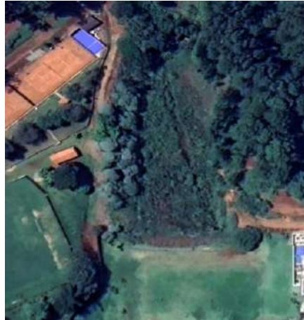
Figura 15 – Barragem do Condomínio.
