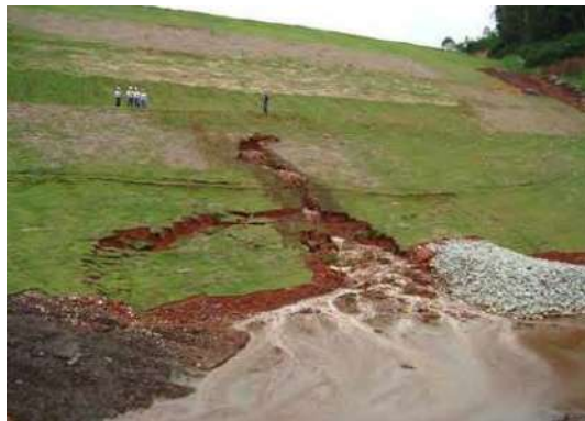
Figura 4 – Efeito de erosão interna no talude de jusante da Barragem do Fundão.
