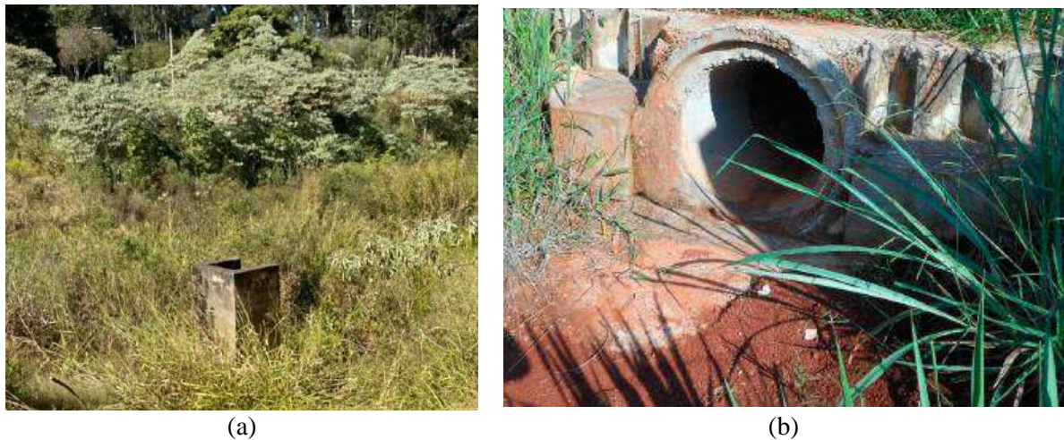
Figura 18 – Monge: (a) Caixa de nível e (b) Galeria.
