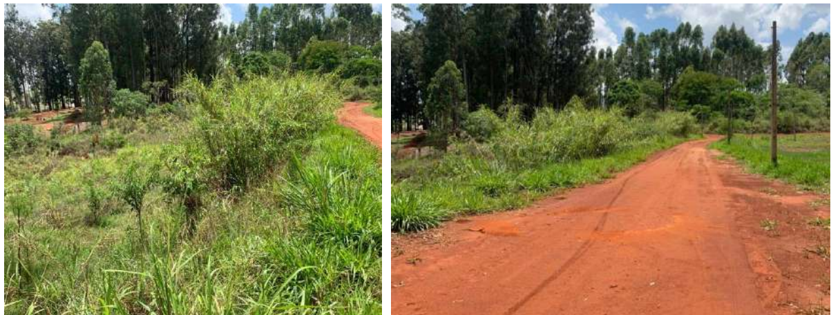
Figura 13 – Talude Jusante e Crista: (a) Talude jusante do barramento e (b) Crista.
