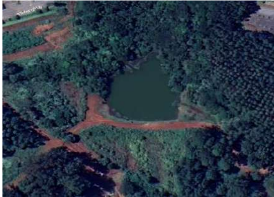
Figura 12 – Barramento Condomínio Montante.
