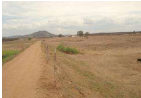
Figura 6 – Zona de vegetação verdejante no talude de jusante em climas secos.
