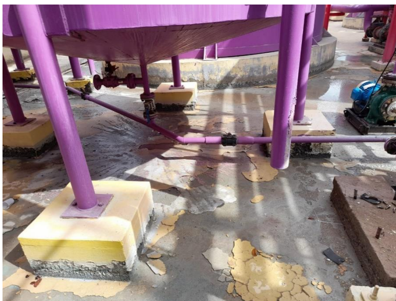
Figura 13 - Base dos tanques.
