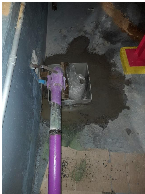
Figura 16 - Novas caixas de drenagem 1.
