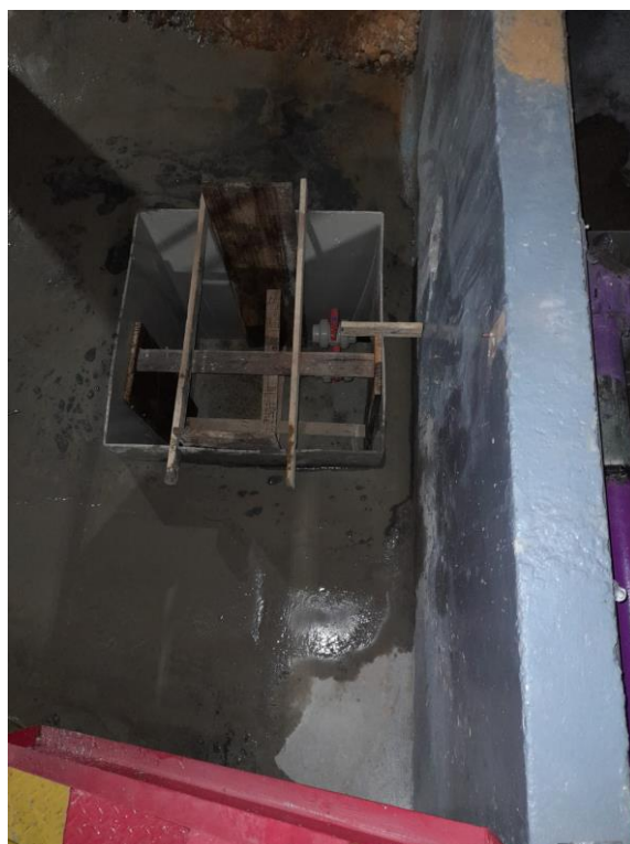
Figura 17 - Novas caixas de drenagem 2.
