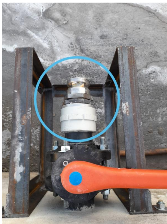
Figura 8 - Representação da válvula de engate rápido.
