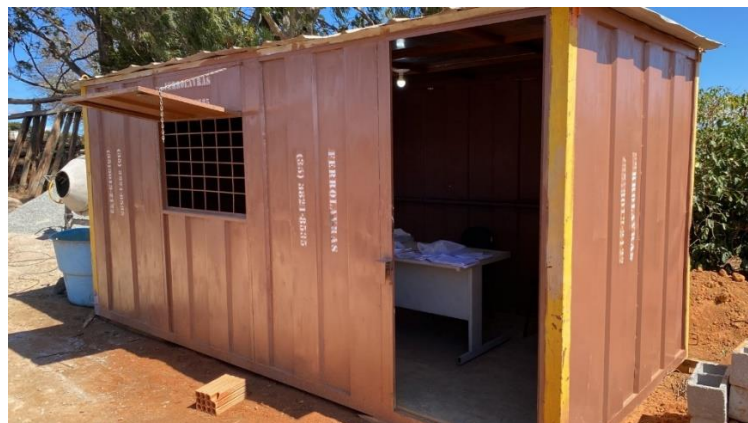
Figura 8– Container montado em formato de base de apoio.
