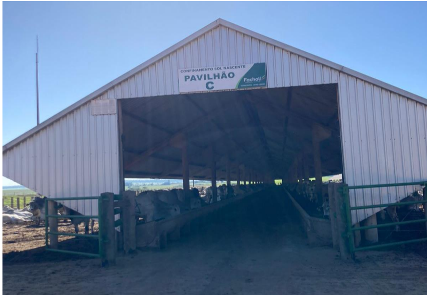
Figura 4. Pavilhão C com instalação coberta e currais concretados. Fonte: arquivo pessoal.
