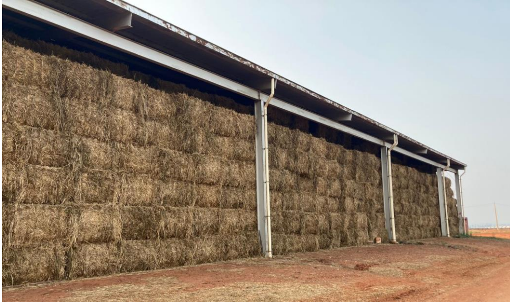
Figura 10. Galpão de armazenagem de feno. Fonte: Arquivo pessoal.
