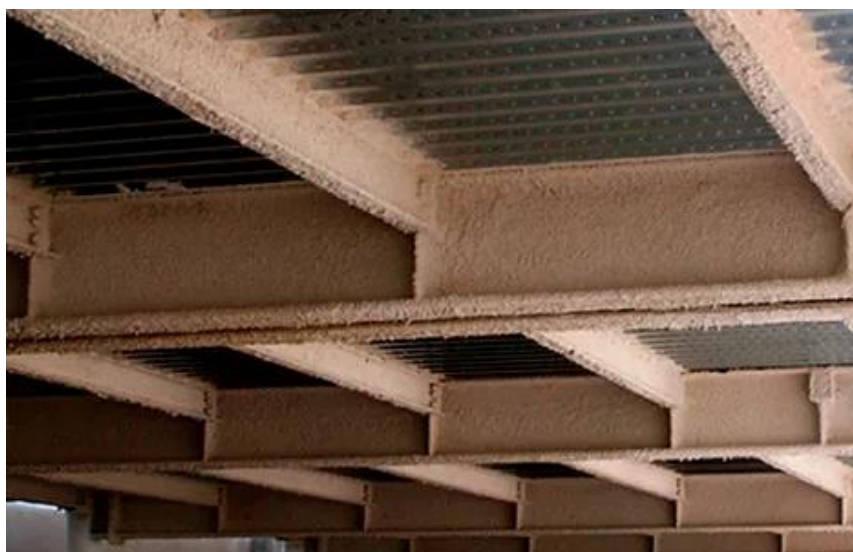
Figura 9 – Argamassa de vermiculita aplicada em viga de aço.
