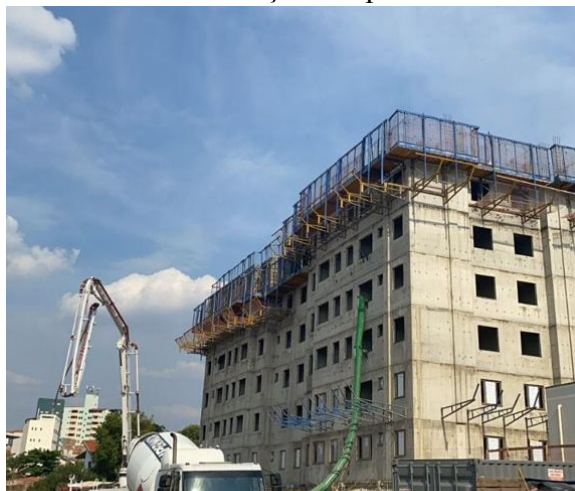
Figura 1 - Edifício em construção em parede de concreto.
