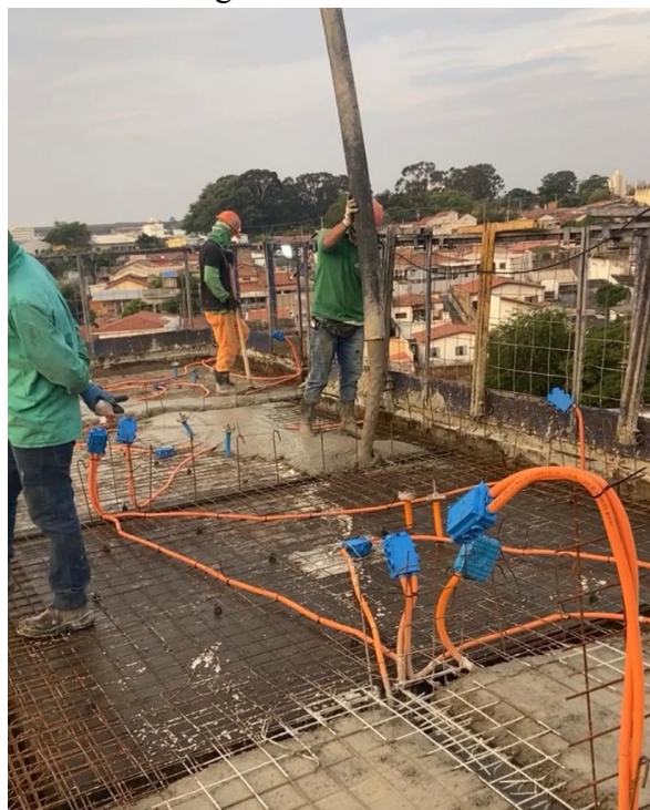
Figura 4 - Concretagem do sistema de Parede Concreto.
