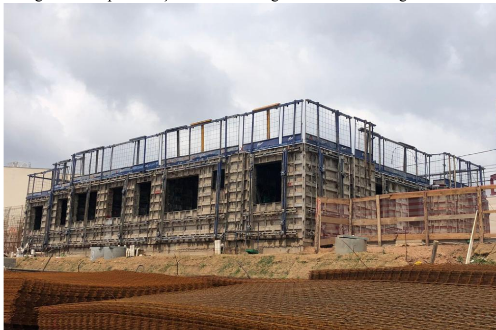
Figura 3 - Representação das fôrmas aguardando concretagem.
