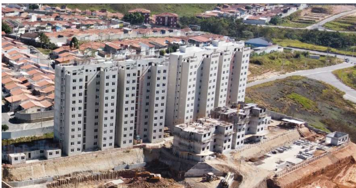
Figura 4.7 - Foto aérea das torres liberadas para assentamento de pisos.
