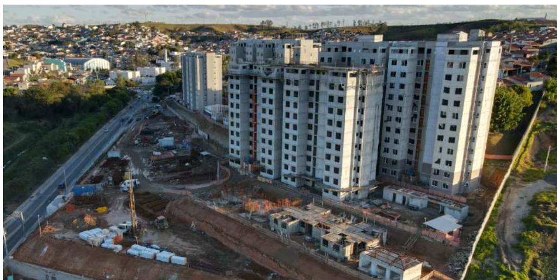
Figura 3.5 - Foto aérea atual da obra Residencial Vista Bela.
