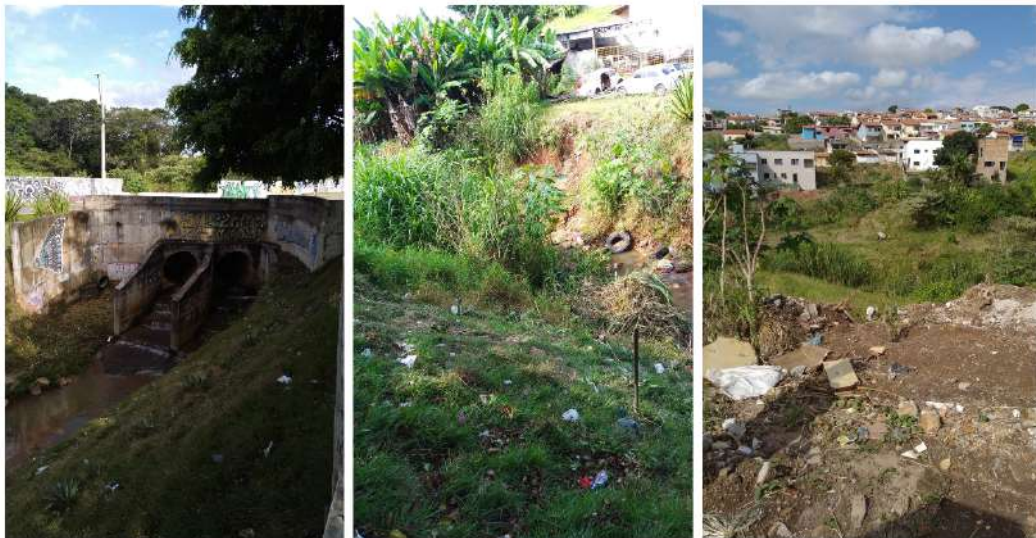
Figura 4 – Lixo em local indevido
