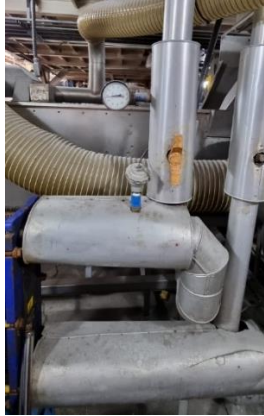
Figura 10 - Mostradores de temperaturas analógicos.
