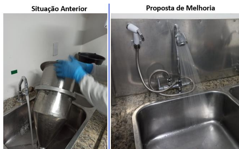
Figura 9 – Melhoria aplicada na torneira da sala de lavagem.
