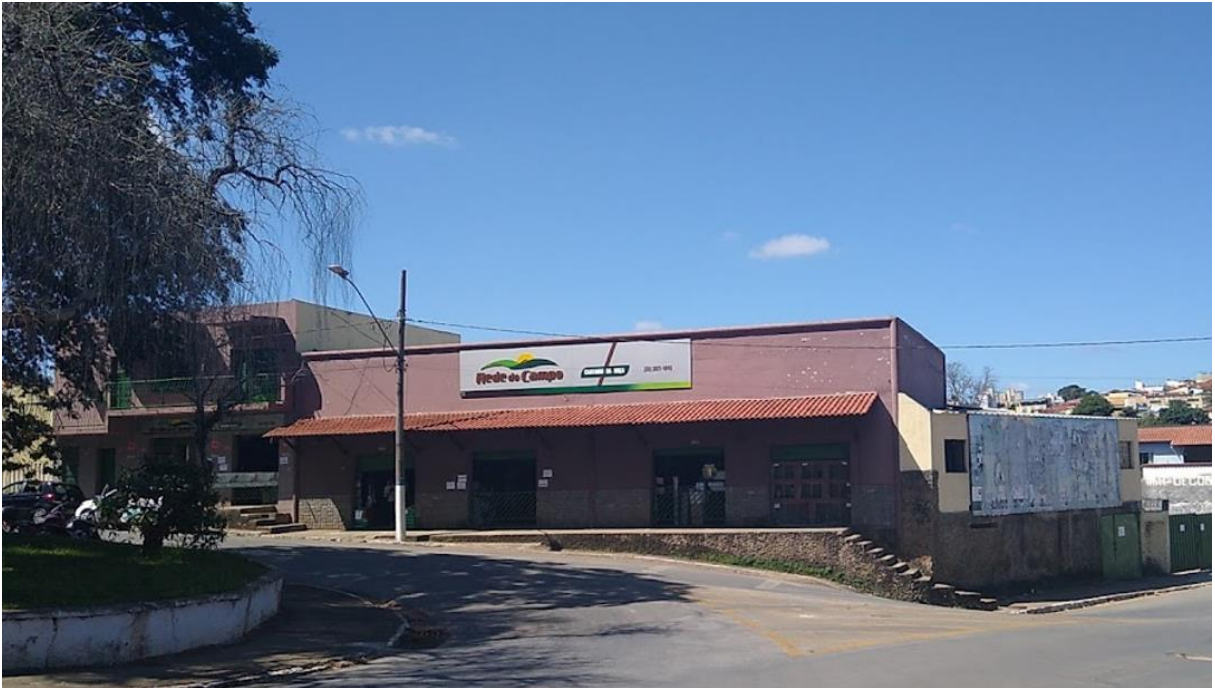
Figura 1 – Fachada da Loja 1 - Matriz, da Rede do Campo - Cantinho da Roça.
