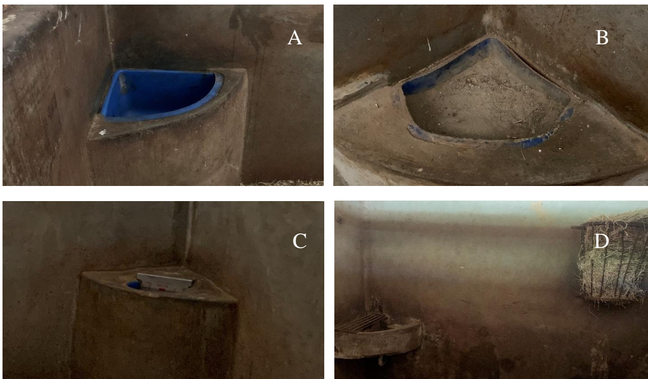
Figura 7: A) comedouro de plástico revestido por alvenaria presente nas baias. B) saleiro de plástico revestido por alvenaria presente nas baias. C) bebedouro de plástico revestido por alvenaria presente nas baias novas. D) manjedoura de ferro para oferta de feno e bebedouro de alvenaria presente nas baias antigas.
