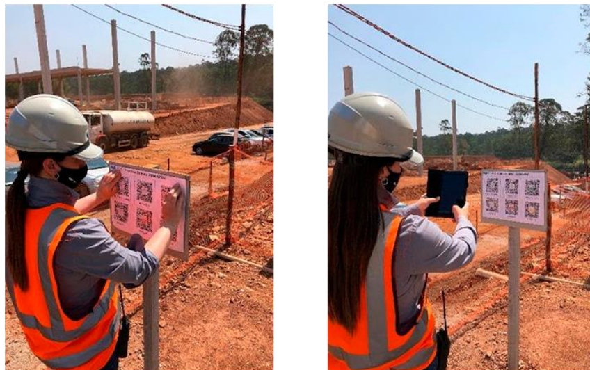
Figura 1a – Exemplo de aplicação do QR Code no canteiro de obras
