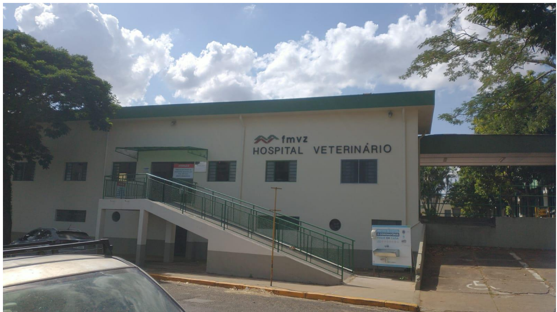
Figura 1 – Fachada do Hospital Veterinário da Faculdade de Medicina Veterinária e Zootecnia da Universidade Estadual Paulista “Júlio de Mesquita Filho”, campus Botucatu.
