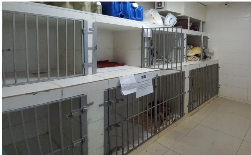
FIGURA 24 – Vista parcial do isolamento acústico
