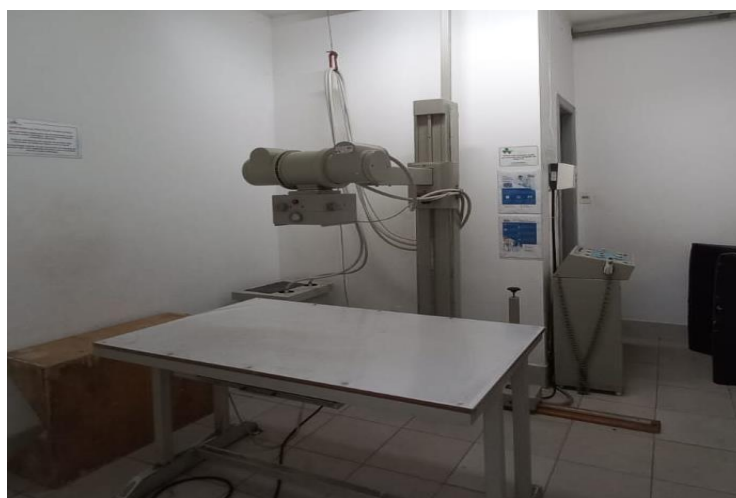
FIGURA 13 – Vista parcial da sala de radiologia.
