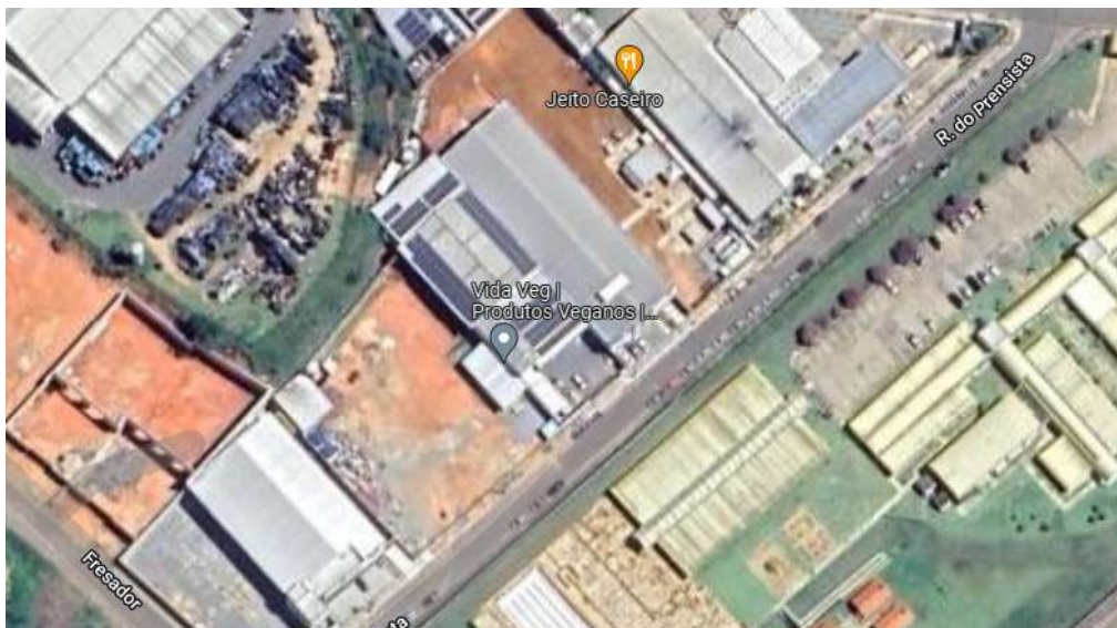
Figura 1 - Imagem aérea do local
