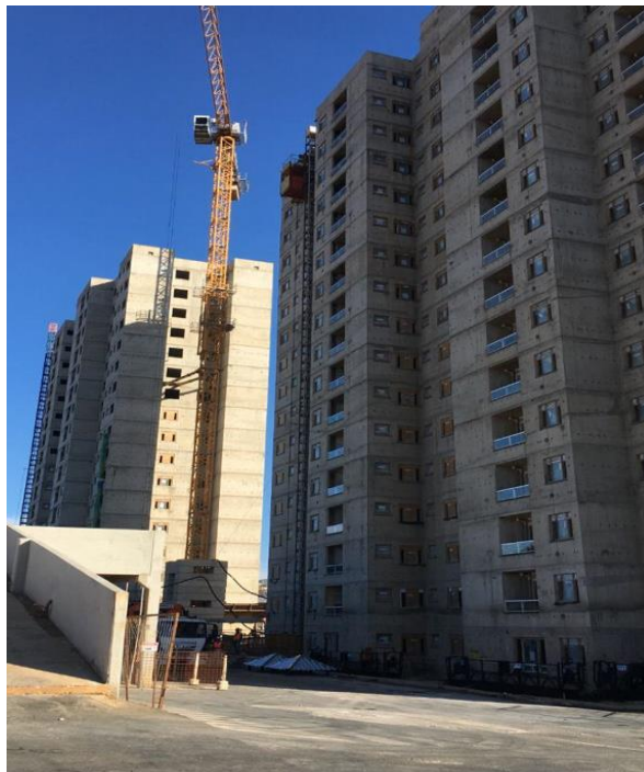
Figura 7 - Torres 1 e 2 do condomínio multifamiliar.
