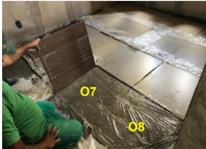
Figura 12 - Placa O7 já assentada sobre o plástico e cordões esmagados. Placa O8 ainda não assentada.
