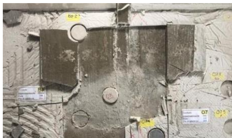
Figura 24 - Retirada de placas do sistema das condições B8 e O7.
