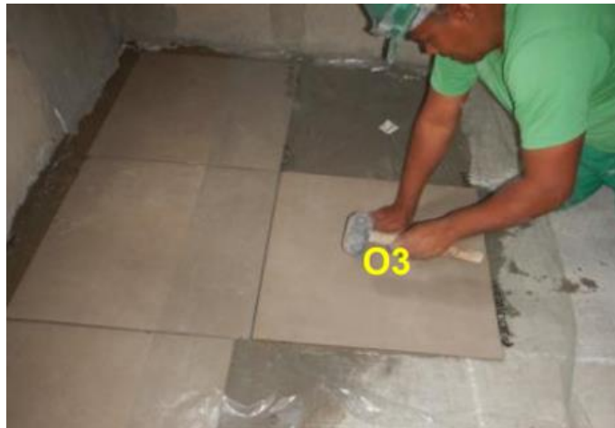
Figura 11 - Assentamento da placa O3 sobre o plástico.
