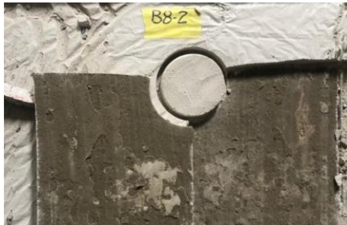
Figura 25 - Condição B8 – Ruptura na camada de impermeabilizante.
