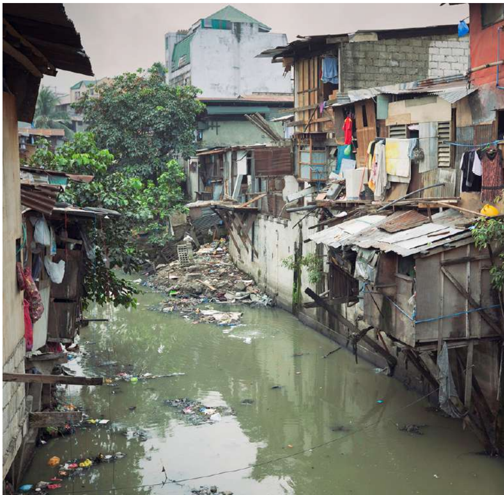
FIGURA 17 - Figura correspondente a esgoto a céu aberto, no distrito de Brasilândia, uma periferia na cidade de São Paulo.
