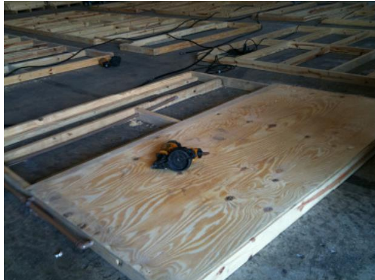
Figura 1 – Fixação das chapas OSB de vedação na estrutura da parede.
