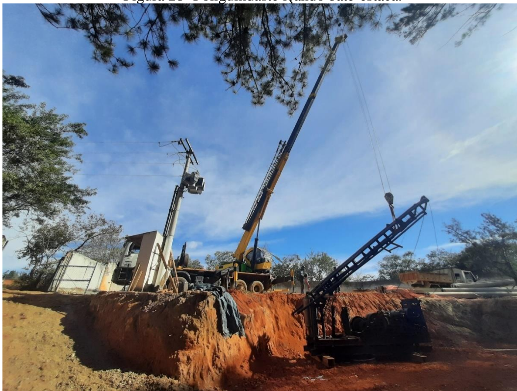
Figura 28- Poliguindaste içando bate-estaca.
