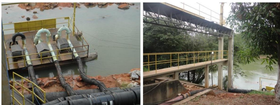
Figura 6- Captação Rio Grande – Baixo Recalque.
