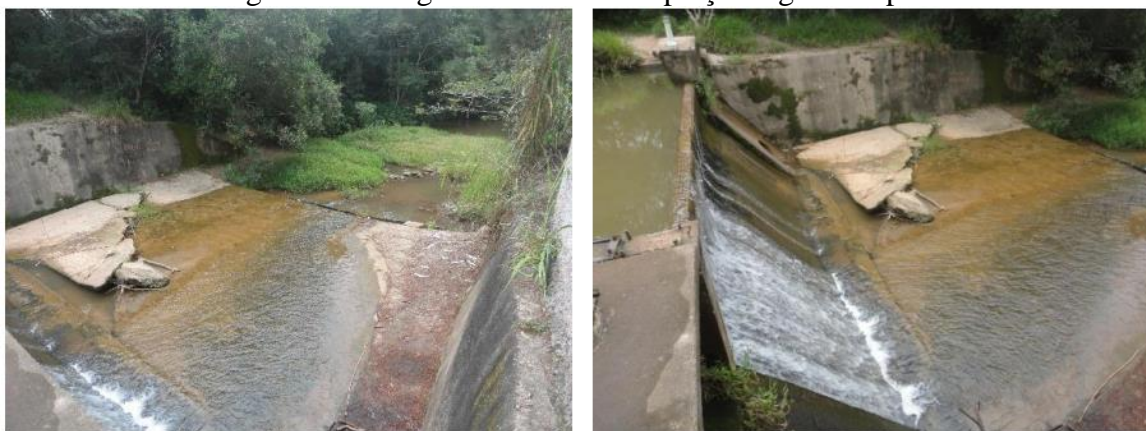
Figura 9- Barragem de nível da Captação Água Limpa
