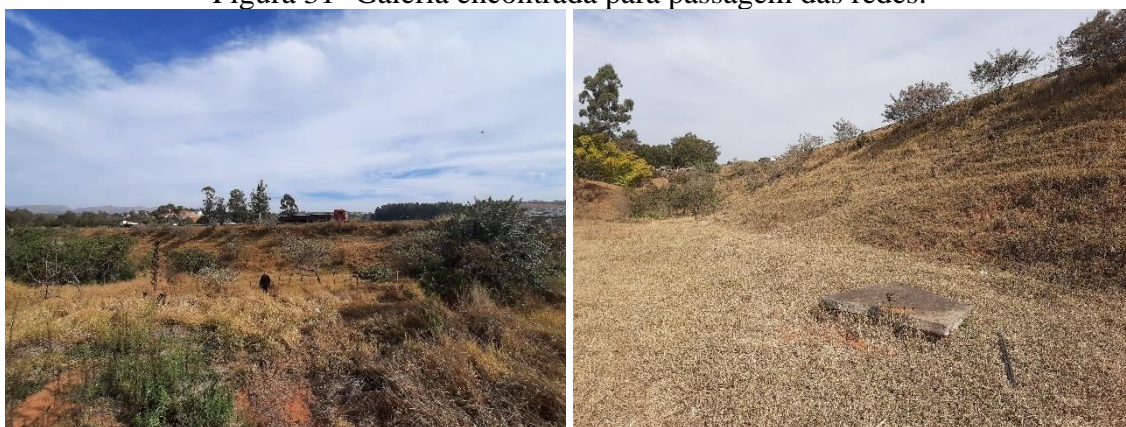
Figura 31- Galeria encontrada para passagem das redes.
