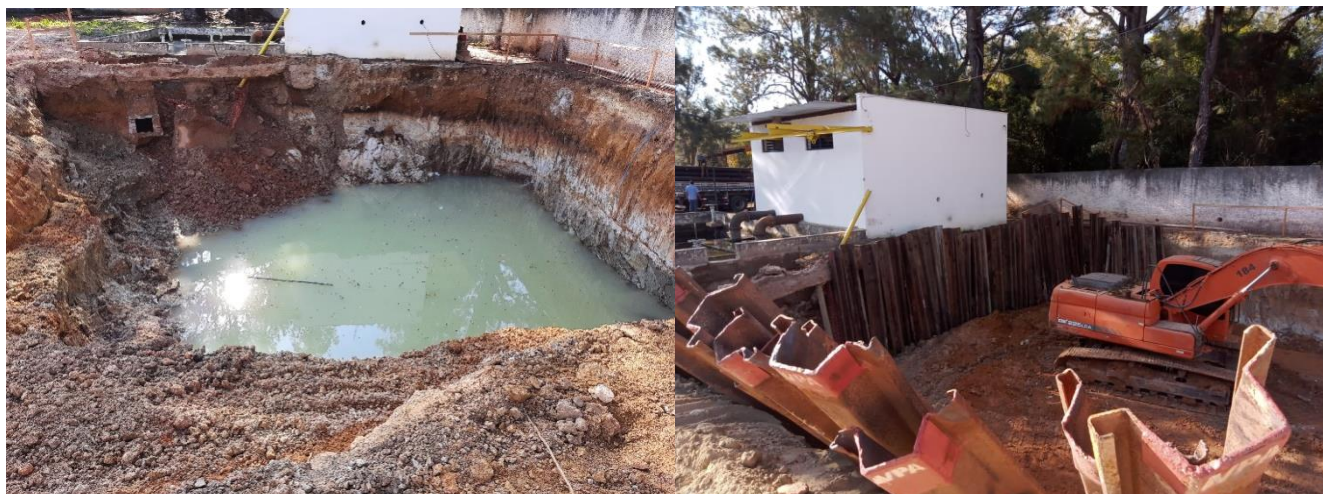
Figura 26- Estacas metálicas instaladas na área escavada.
