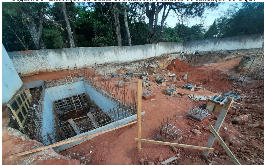
Figura 30- Execução da Caixa de Manobra e estacas de fundação do TQS.
