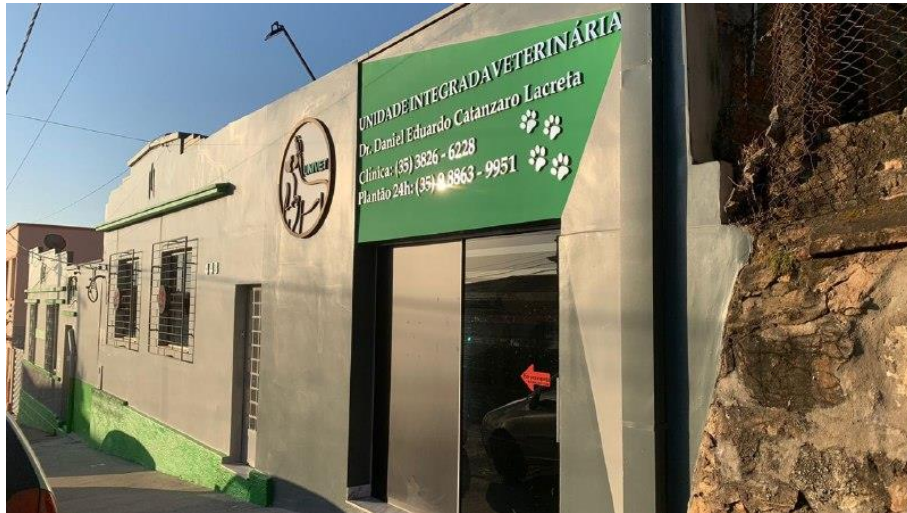
FIGURA 1 - Vista frontal Unidade Integrada Veterinária.
