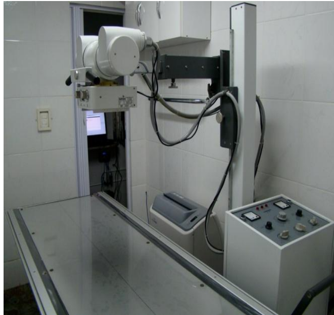
Figura 3 – Sala de exames radiográficos da Clínica Veterinária Vetmaster, Belo Horizonte/MG.
