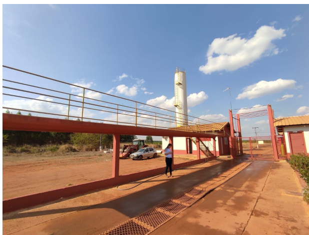
Figura 2: Local de lavagem de veículos
