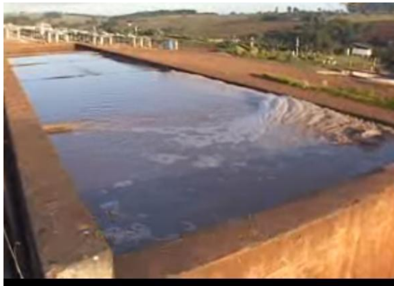
Figura 24 - Resíduos líquidos na Estação de Tratamento de Efluentes (E.T.E).
