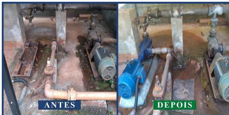
Figura 3 – Antes e depois da reativação da Bomba reserva da ETA.
