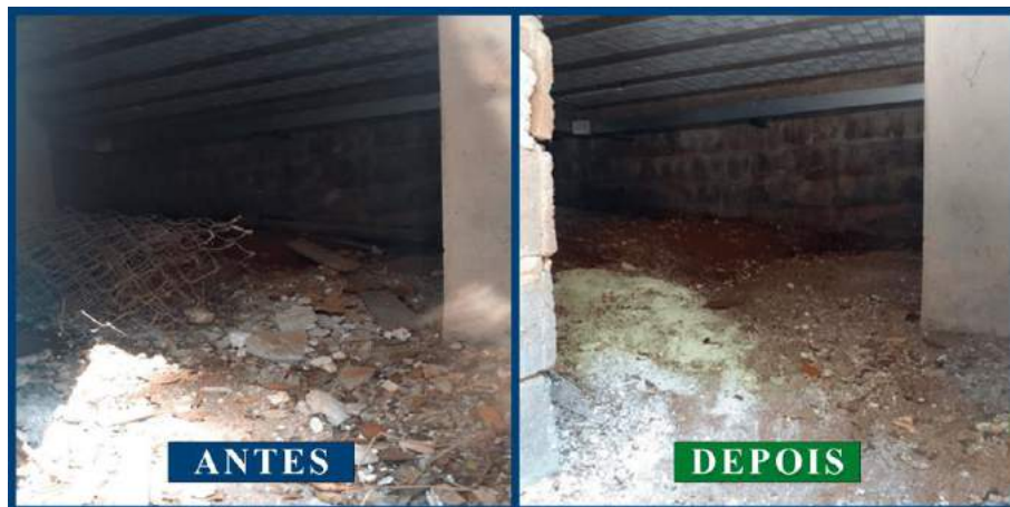
Figura 5 – Porão antes e depois da retirada dos materiais oriundos de obras.
