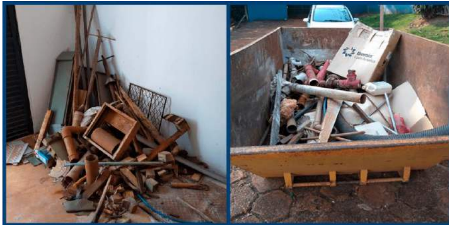
Figura 4 – Acúmulo materiais oriundos de obras e manutenções e descarte.
