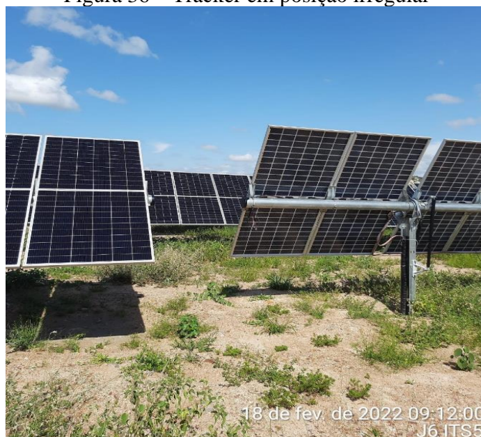
Figura 36 – Tracker em posição irregular
