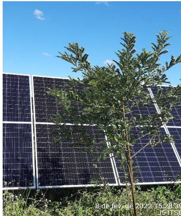
Figura 22 – Sombreamento causado pela vegetação elevada
