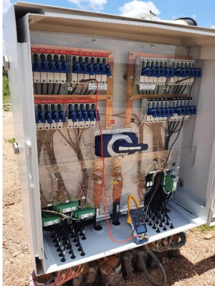
Figura 15 – Teste de VOC
