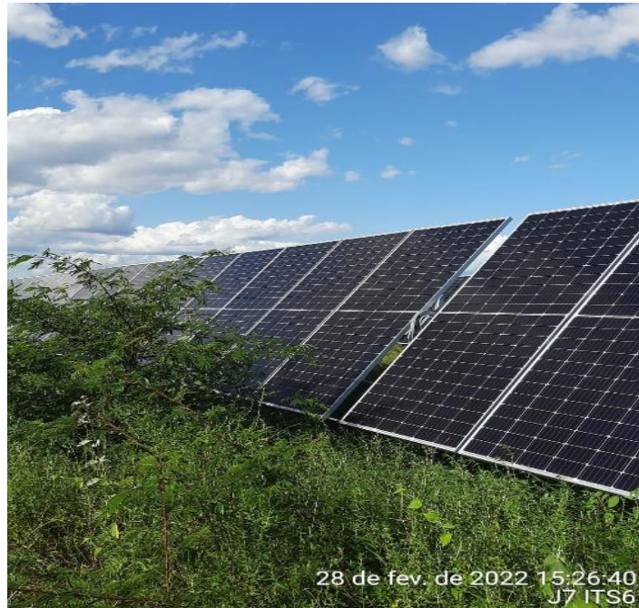
Figura 20 – Sombreamento causado pela vegetação elevada
