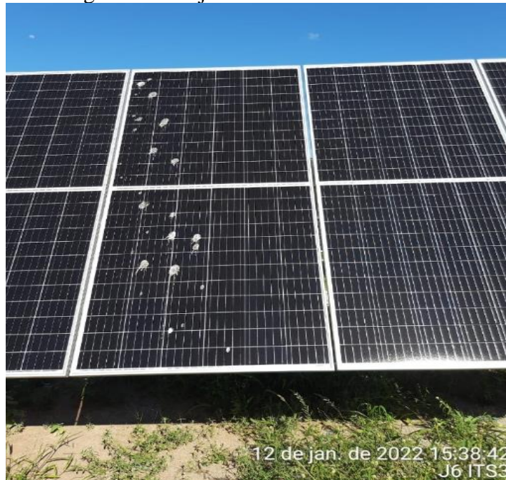
Figura 35 – Sujeira sobre o módulo
