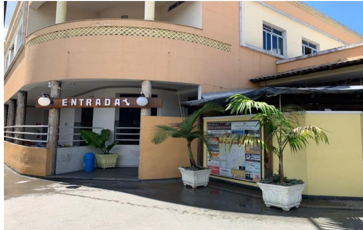
Figura 4 – Entrada do Restaurante.
