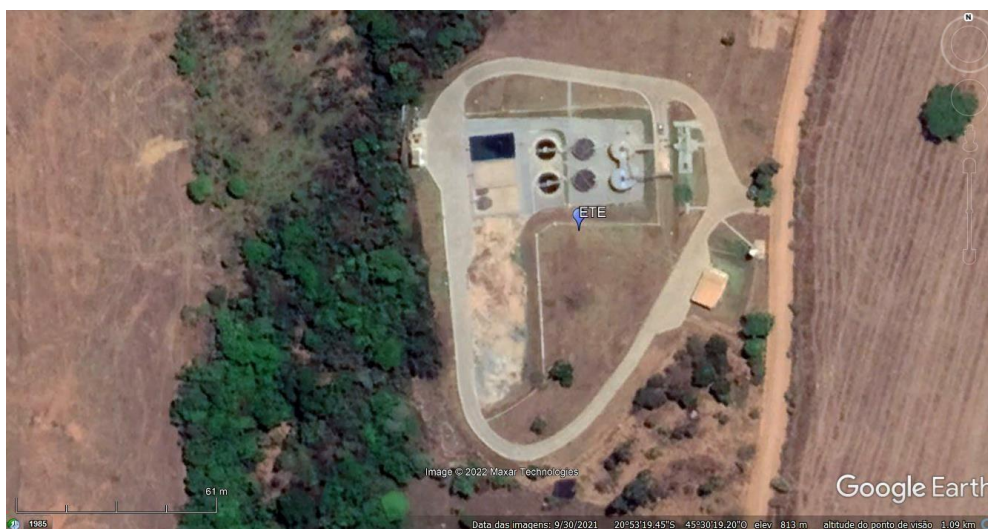
Figura 4: Estação de tratamento de esgoto de Cristais - MG.
